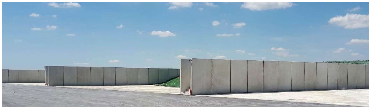
Casiers de stockage des matières solides (CA02)
