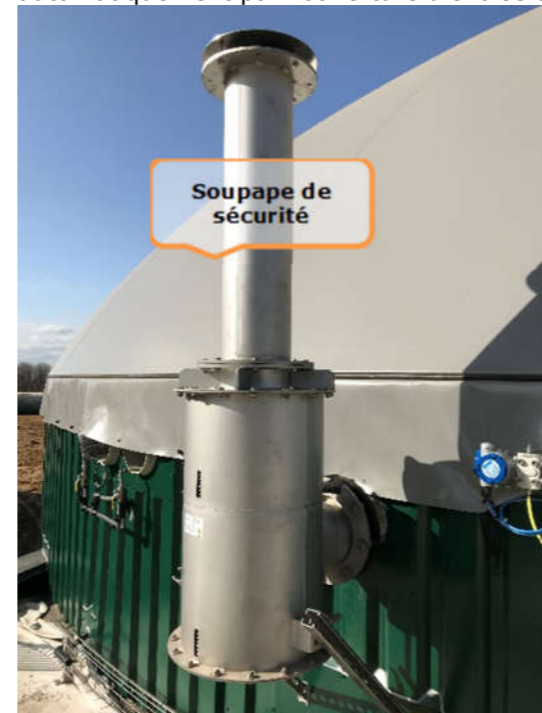
Photo : Système de protection contre les sur/sous-pressions, présent sur un site analogue à BIOCROPS (CA02) et schéma de principe.
