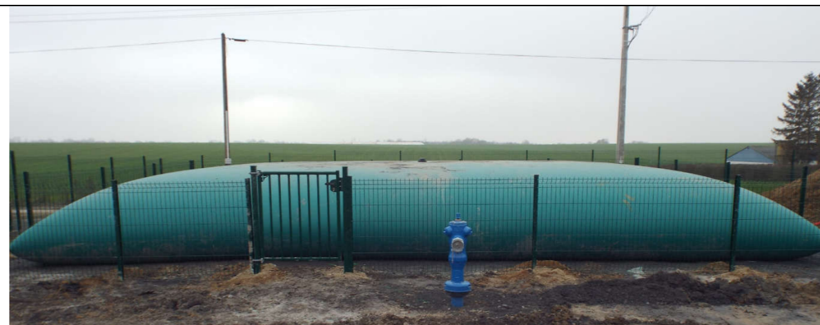
Photo : Poche de défense incendie présente sur un site de méthanisation similaire à BIOCROPS (CA02).
